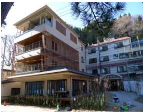
再建した新館
