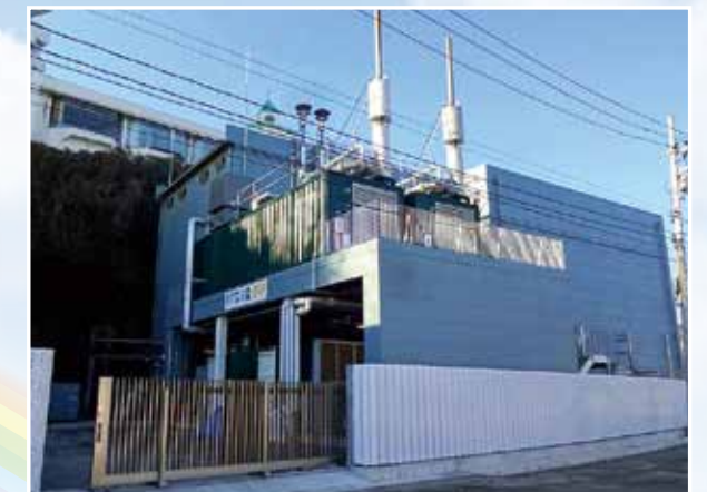
プラント外観
