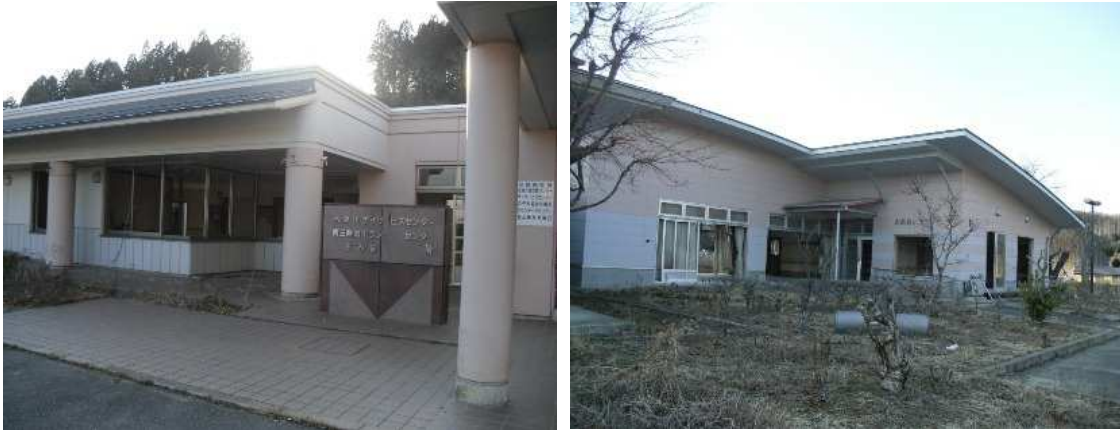
【震災後の志津川地区のデイサービスセンター】
