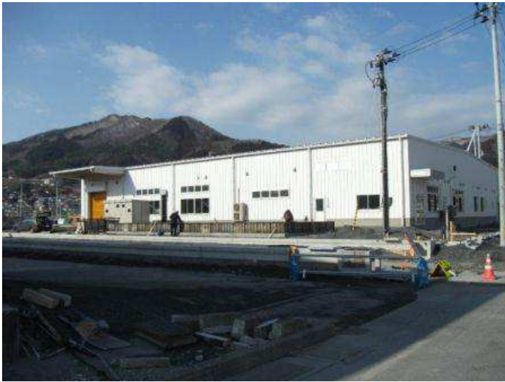
◇本日より稼働した大船渡フレック工場
