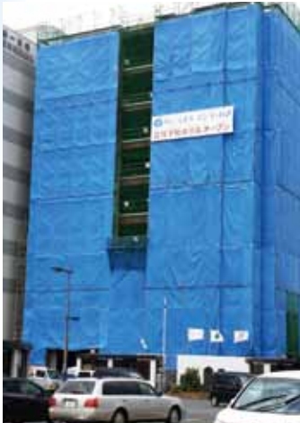
ホテルの建設現場
