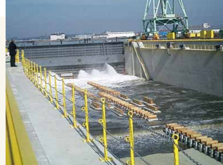
安全祈願祭で船舶修繕ドック（長さ170m、幅36m、深さ8m）に海水が注入される様子
