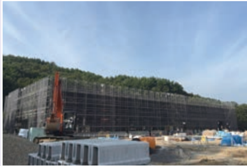
ふくしま逢瀬ワイナリー建設中の様子
